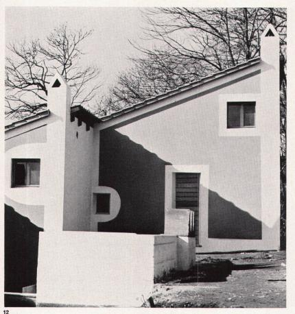
des Wohnraumes bildet. Die Haustypen ( $5.6 \times 5.6$  Meter im Außenmaß) enthalten im Erdgeschoß einen Wohn-Eßraum mit einem oder zwei Couchbetten sowie einen Toilettenraum mit Dusche, einen 50-Liter-Warmwasserboiler, eine Kochkombination und einen Ölofen, darüber zwei Galeriekammern mit 2 resp. 3 Betten. Sie bieten einer Familie bis zu sieben Personen Platz.
