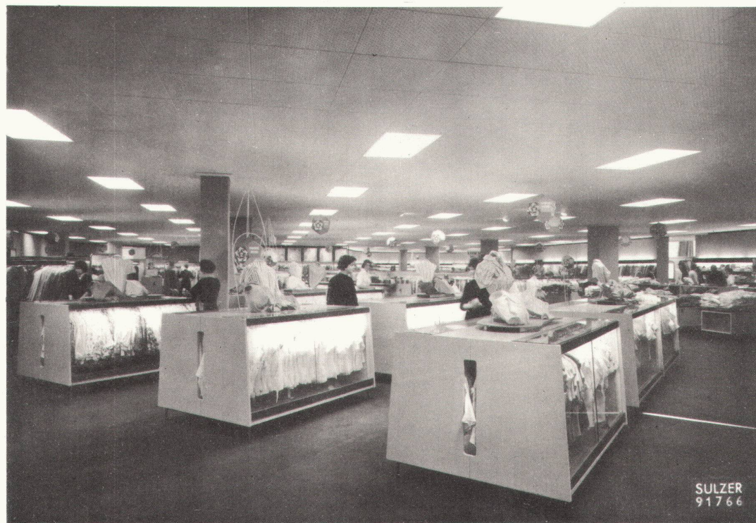
Verkaufsraum eines grossen Warenhauses mit Sulzer- Luftkonditionierungsanlage
