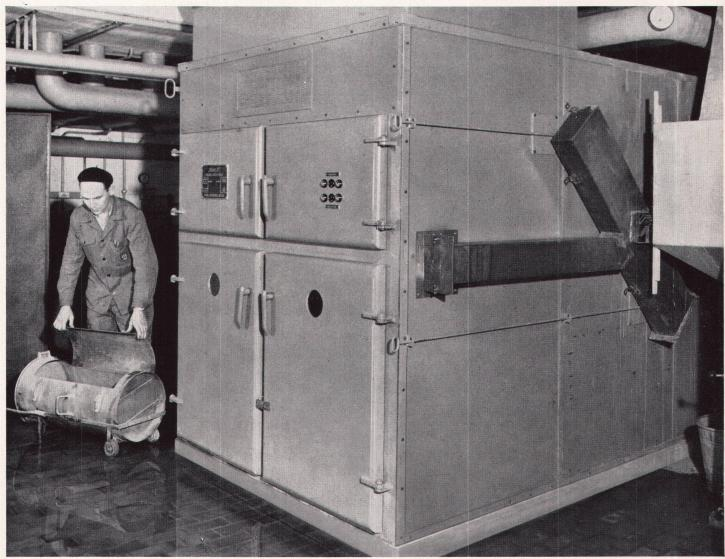
Vollautomatischer MenS-Kokskessel, System Möring, mit einer Leistung von 700000 kcal/h. Vertreten durch: Ideal-Standard AG, Dulliken SO
