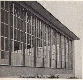
ALSEC-Leichtmetallprofile K = 2,25 - 2,5 Isolierglas-Elemente K = 2,5 - 3,0
