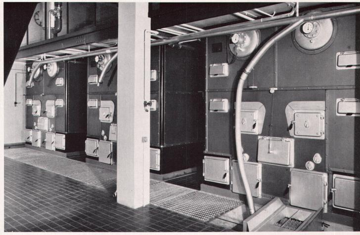
Für das gesamte Areal der sogenannten Sandgrube in Basel wurde eine Fernheizungszentrale erstellt. Sie verbrennt grobkörnigen Koks. Die neuen Gebäulichkeiten der Gewerbeschule, d. h. zwei 7geschossige Schultrakte und fünf 1geschossige Werkstatttrakte, sowie das Schulhaus Sandgrube mit allen Nebengebäuden werden von dieser Zentrale mit Wärme versorgt.
