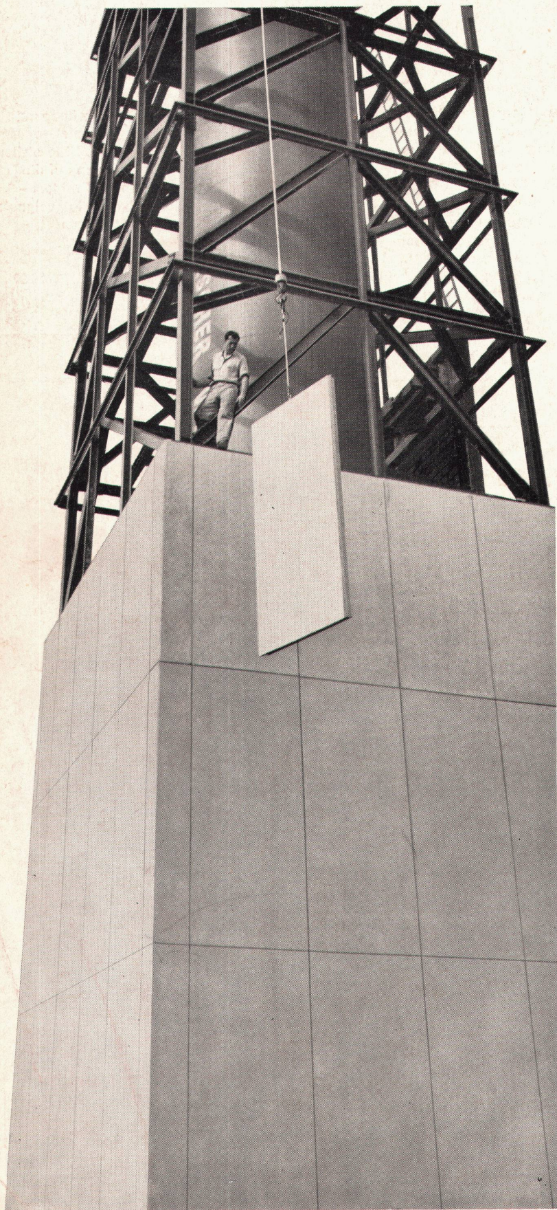
Heizturm der Flughafen-Immobilien-gesellschaft, Kloten Montage von vorfabrizierten Fassadenelementen aus Leca-Blähton
