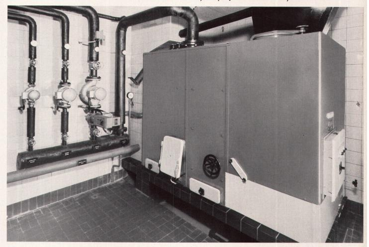
Automatischer Soccarex-Kessel von 310 000 kcal/h Leistung. Vertreten durch: Surac S.A., Genf.
