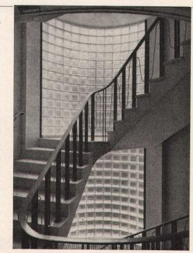
Moderner GLAS-BETONBAU begeh- und befahrbare Oberlichter und Wände
