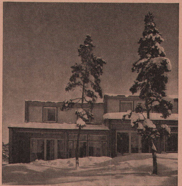
Reihenhaussiedlung in Bagarmossen Architekten: L. und Ch.-E. Geisendorf, Stockholm und Zürich
