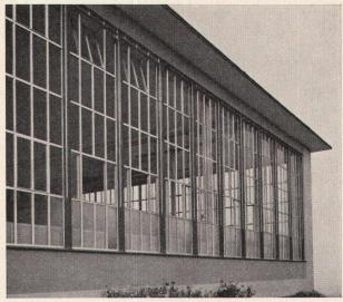
ALSEC-Leichtmetallprofile K = 2,25 - 2,5Isolierglas-Elemente K = 2,5 - 3,0
