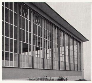
ALSEC-Leichtmetallprofile K=2,25-2,5 Isolierglas-Elemente K=2,5-3,0
