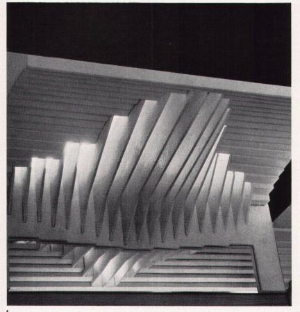
. Ausbildung der Kirchendecke im Innern mit plastisch geformten La-mellen. Blick von unten gegen Decke, Modellaufnahme Le plafond à lamelles moulées de la nef; vue d'en bas (maquette) Church ceiling with lamellae. Model photograph taken from below
