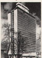
Mitten im Industriequartier von Ludwigshafen (Deutschland) steht das neue Verwaltungsgebäude der BASF. Über 1000 Jettair®-Apparate sorgen hier für optimales Arbeitsklima. Jettair heizt im Winter, kühlt im Sommer, ventiliert, befeuchtet oder entfeuchtet die Luft und ist individuell regelbar.
