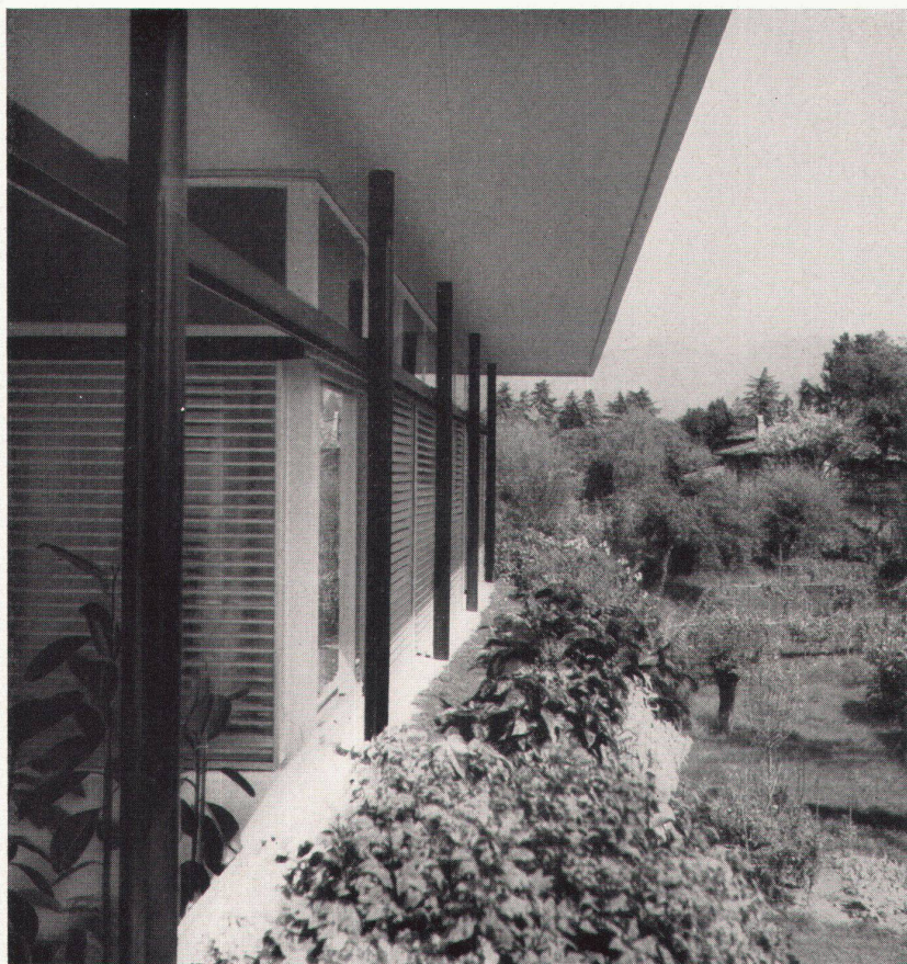
7 Detail der Balkonbrüstung mit schiebbaren Aluminiumjalousien Détail de la balustrade du balcon, avec jalousies réglables en aluminium Detail of balcony parapet with slidable aluminium sunshades
