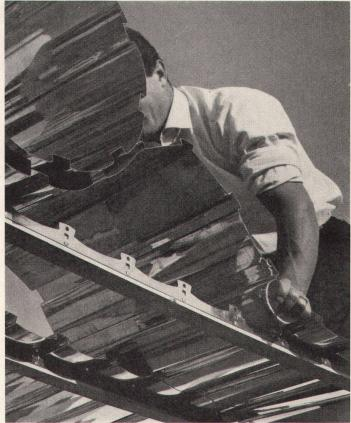
EDAK-Profile für Säulen-, Fassaden- und Wandverkleidungen usw.
