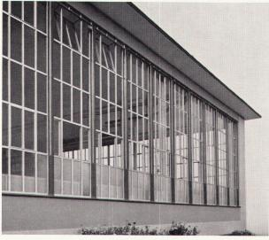
ALSEC-Leichtmetallprofile K=2,25-2,5 Isolierglas-Elemente K=2,5-3,0
