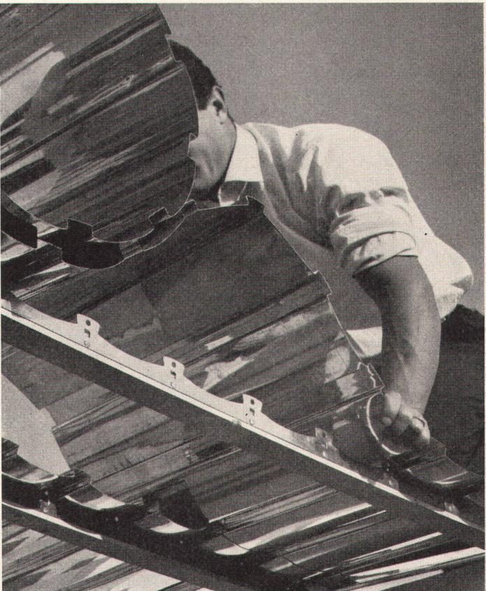
EDAK-Profile für Säulen-, Fassaden- und Wandverkleidungen usw.
