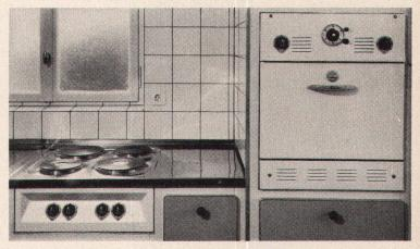
Der Grosse Backofen mit Thermostat und «Timer», der sich als Einzelelement auch in Sichthöhe einbauen lässt, kann mit einem Infrarot-Grill geliefert werden. Zu den vielen anderen Vorteilen des Bel-Door-Herdes gehören auch das schräge Schaltpult, das rote Warnlicht, die «gasgleiche» Schnellheizplatte, die beheizte Geräteschublade, die vollendete Formschönheit und – vor allem – die Garantie des Namens «Prometheus».
