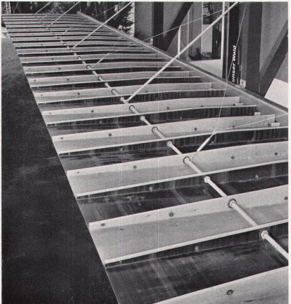
Projekt einer Shedhalle aus verleimten und gekrümmten Sperrholzschalen (Kastenträger), Modellaufnahme. Projektierung: Ing. H. Hossdorf, Basel, und Lignoform AG, Benken Projet d'un hall en shed, formé par des éléments en bois contre-plaqué, collé et courbé (support en forme de caisson); maquette Project of a shed structure of glued and curved plywood casings.
