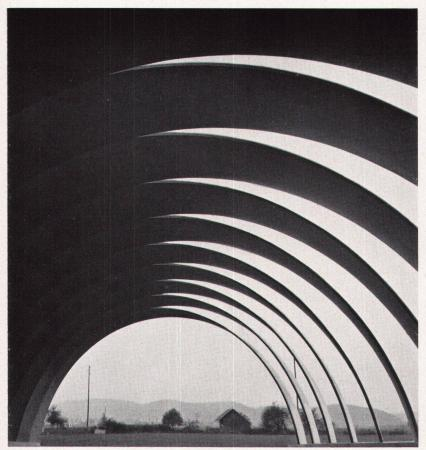
Sheddach in Rostbauart, Spannweite 20 m. Konstruktionsschema und Bahntransport der fertigen Shedschale. Projektierung: Dr. E. Staudacher, Zürich; Ausführung: Gribi & Co. AG, Burgdorf, Osterwald und Bischof, St. Gallen
