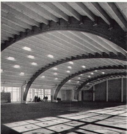
der Richtung einer verfeinerten Bauprofilgebung getan, wie sie etwa im Metallbau besteht. Die in hohem Maße steifen und tragfähigen Bauprofile ergeben mit geringem Materialaufwand interessante baukonstruktive Holzverwendungen, sofern es gelingt, die Herstellungskosten dieser qualitativ hochwertigen Sperrholzelemente in konkurrenzfähigem Rahmen zu halten.
