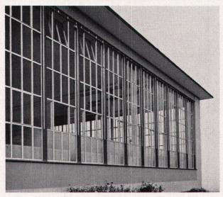
ALSEC-Leichtmetallprofile K=2,25-2,5 Isolierglas-Elemente K=2,5-3,0
