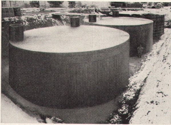
Tankanlage für ein kantonales Elektrizitätswerk, Inhalt 600 000 Liter
