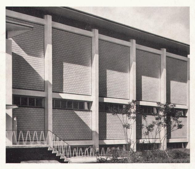
Ausfachung eines Eisenbetonskelettes mit Sichtmauerwerk aus breitgerippten Kalksandsteinen
