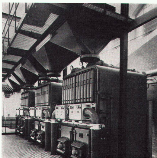
Sulzer-Taschenkessel zur Erzeugung von Warm- und Heißwasser
