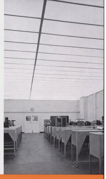
Die REGALUX-Decke wirkt dank ihrer gleichmässig hellen Fläche im eingeschalteten und ausgeschalteten Zustand grosszügig und modern. Keine Lichtquellen und keine Installationen sind sichtbar. Da von der REGALUX-Decke ein gleichmässiges, angenehmes Licht in den Raum strahlt, treten weder Blendung noch harte Schatten auf. Die REGALUX-Decke ist in gleicher Weise geeignet für Neubauten wie für die Neubeleuchtung bestehender Räume.
