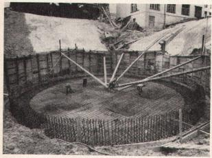
Tank für Kautschukfabrik, Fundamentplatte Ø 17,00 m, Inhalt 1,5 Mill. Liter
