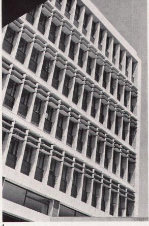
Detail der Südfassade mit Brise-soleil Détail de la façade sud avec brise-soleil South elevation detail with sun-shield
