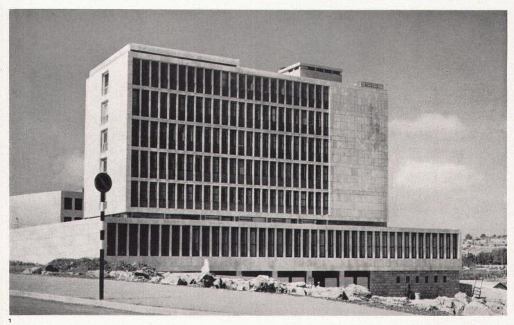
Der University Campus von Jerusalem entsteht auf einem Kalksteinhügel mit einer Fläche von 300000 m² für Gebäude und Gärten. Die Gebäude werden nach der Abhangseite hin in die Tiefe gebaut (bis zu zwei Stockwerken). Das Gestein für Grundmauern und auch für die Bauten selber wird an Ort und Stelle ausgegraben und von Hand bearbeitet. Die Steine werden vielfach in wildem Verband gemauert.
