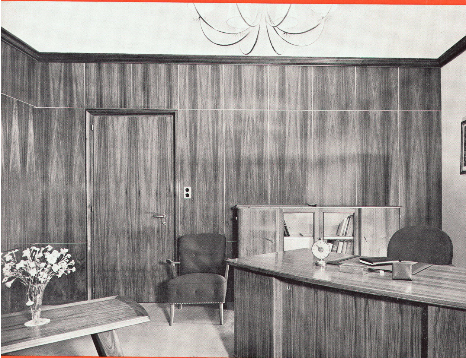
Schweizerische Bankgesellschaft, Montreux Schreinerarbeiten und Innenausbau mit TAVAPAN-Platten. Nußbaum furniert, gebeizt und mattiert Ausführung: Menuiserie - Ebénisterie Modèle. Albert Held & Cie S. A., Montreux
