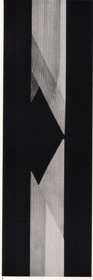
1 Horizontale Längsverbindung von zwei Hölzern oder Balken, ausgeführt nach japanischer Handwerkstradition Jonction horizontale de deux morceaux de bois ou de deux poutres, exécutée selon l'ancienne tradition artisanale japonaise. Longitudinal bond of two wooden strips or logs, executed according to old Japanese craftsmanship tradition
