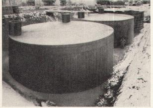
Tankanlage für ein kantonales Elektrizitätswerk, Inhalt 600 000 Liter
