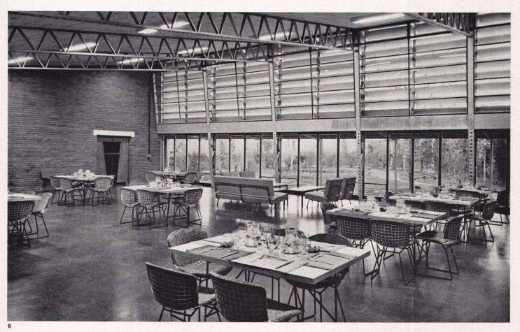
4 Südfront eines Speisesaales mit lamellenverkleideten Oberlichtern Face sud d'un réfectoire, avec les jours protégés par des lamelles South elevation of a dining-room with lamella-panelled skylights
