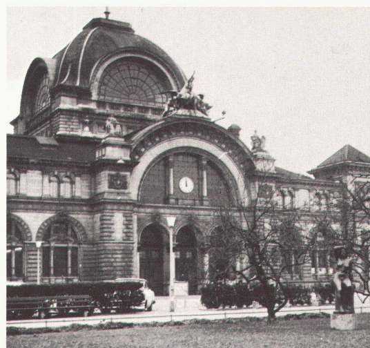
Auch hier liegt Plastofloor «Dätwyler». Bahnhofbuffet Luzern, I. und II. Klasse.
