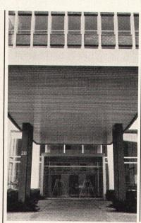
STRUCTAL-Bedachung am Vorbau Verwaltungs-Hochhaus J. R. Geigy AG, Basel. STRUCTAL ist formschön, dauerhaft, unsichtbar befestigt, kann frei dilatieren und läßt sich bis zu 1-2% Gefälle wasserdicht verlegen.
