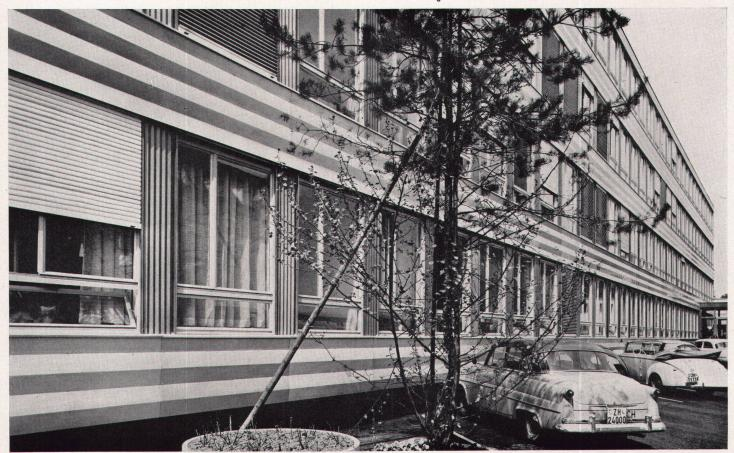
Die Fassadenbrüstung trägt eine natureloxierte Aluminiumverkleidung mit durchgehender Horizontalprofilierung; die Verkleidung der Fensterpfeiler ist stahlblau eloxiert. Die Bauelemente, wie Fassadenteile, Zwischenwände und Türen, konnten weitgehend genormt werden, da das ganze Gebäude auf einem Raster von 2,06  $\times$  2,06 Meter aufgebaut ist.
