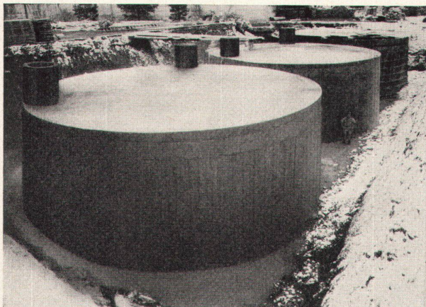
Tankanlage für ein kantonales Elektrizitätswerk, Inhalt 600 000 Liter
