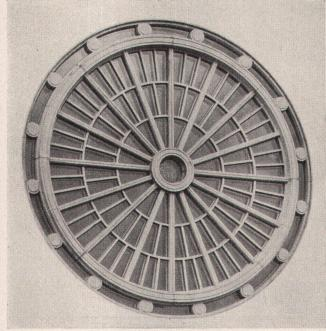
Vorfabrizierte Rosette in Beton, Bruderklausenkirche Bern. Architekt: H. Baur BSA, Basel Betonfenster, Fassadenelemente in Beton und Kunststein, Konstruktionselemente, wie Pfeiler, Dachbinder, Pfetten, Balken, Rahmen mit schlaffer und vorgespannter Armierung. Unsere Fabrikationsmethoden erlauben uns, weitgehend auf die Wünsche unserer Kundschaft einzugehen. Wir beraten Sie gerne bei der Lösung Ihrer Probleme.
