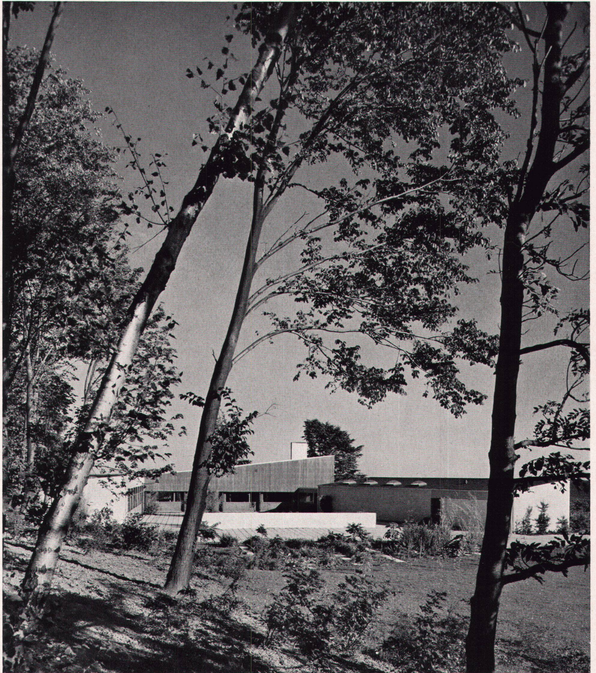
1 1957, Architekt: Arne Jacobsen MAA, Kopenhagen
