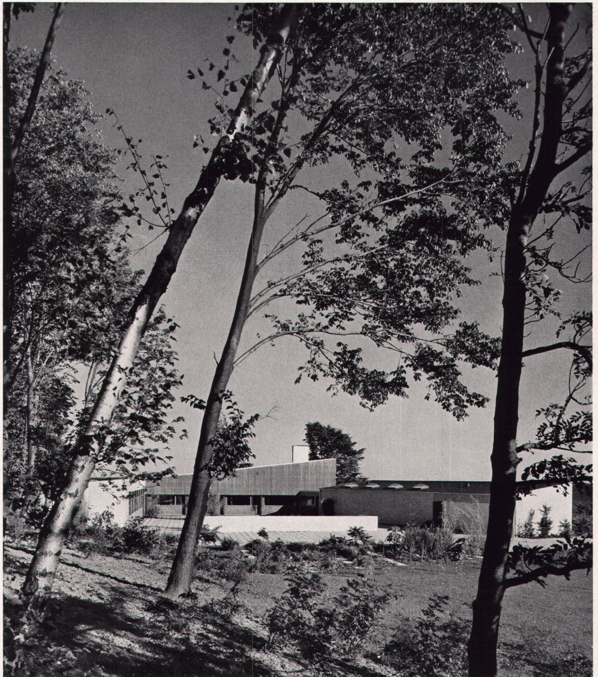
1 1957, Architekt: Arne Jacobsen MAA, Kopenhagen
