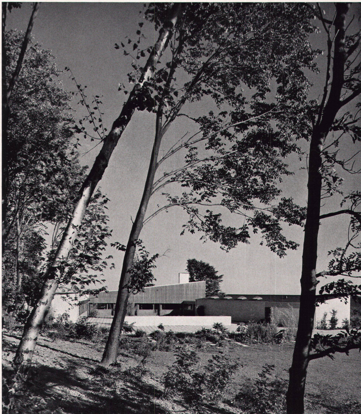
1 1957, Architekt: Arne Jacobsen MAA, Kopenhagen
