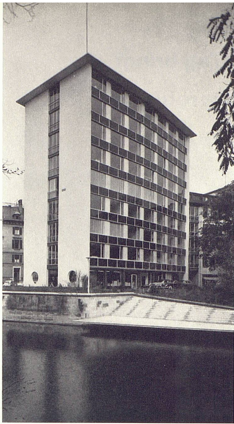
Geschäftshaus mit Sulzer-Strahlungsheizung
