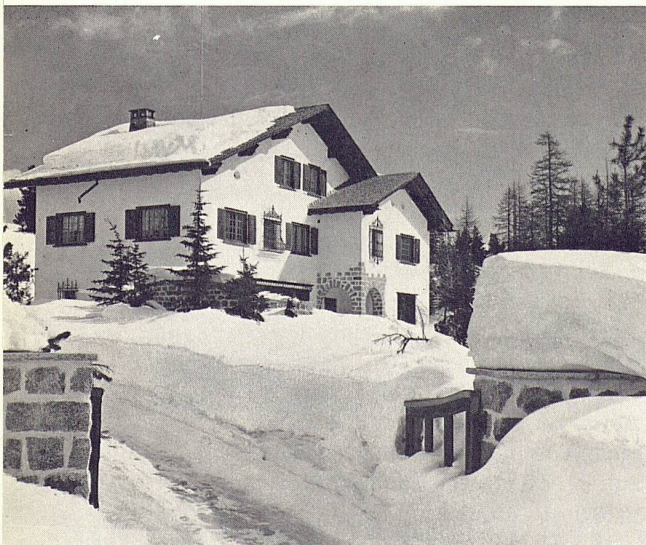
Landhaus im Engadin mit Sulzer-Zentralheizung
