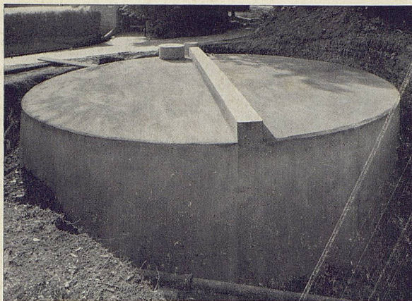
Tankanlage für eine Werkzeugmaschinenfabrik, Inhalt 200 000 Liter
