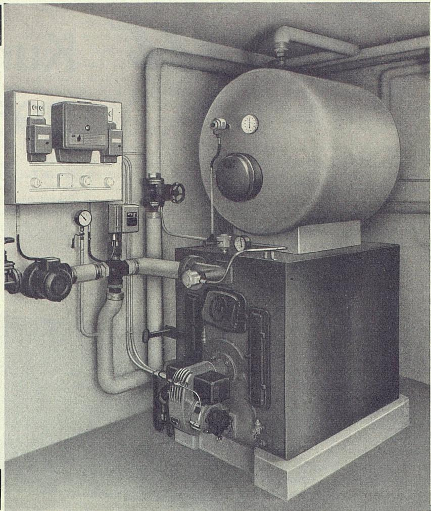
Die IDEAL-BITHERM-Kessel-Boiler-Kombination ist die denkbar einfachste, billigste und zweckmäßigste Lösung dieses Problems. Ein und derselbe Kessel, vollautomatisch gesteuert, dient dem Winter- und Sommerbetrieb.
