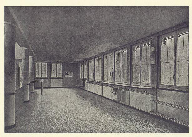
Abbildung zelgt eine Installation mit Rayrad in Decke und unter Fenstern
