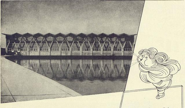
Dieses am Rheinufer gebaute Kraftwerk, das mit vier 30000 PK Kaplan-Turbinen und vier 28000 PK Generatoren ausgerüstet ist, hat eine jährliche Leistung von 555000000 kWh.
