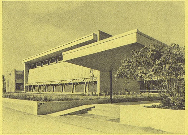
Wohlfahrtshaus der Firma Wild AG in Heerbrugg Architekt: Ernest Brantschen BSA/SIA, St. Gallen
