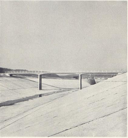
2 Vorgespannte Straßenbrücke über den Oberwasserkanal des Kraftwerks Wildegg-Brugg bei Villnachern. Schlanke, geradlinige Gestaltung bei minimaler Konstruktionshöhe. Aufnahme vor Staubeginn Pont en béton précontraint sur le canal du barrage de Wildegg-Brugg, près de Villnachern. La photo est prise avant que le canal soit rempli Bridge of prestressed concrete of the Wildegg-Brugg weir near Villnachern, the photograph being taken when the canal was still empty
