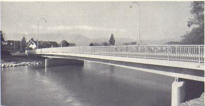
Straßenbrücke über den Unterwasserkanal des Kraftwerks Wildegg-Brugg bei Umiken. Kontinuierlicher Übergang der Pfeiler in den Brückenkörper (normaler Eisenbeton) Pont sur le canal de fuite du barrage Wildegg-Brugg Bridge on the upper canal of the Wildegg-Brugg weir
