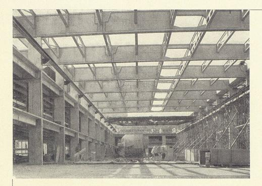
Vorgespannte Dachbinder und Fachwerkpfetten eines Fabrikneubaues Die Montage erfolgte mit eigenem Personal innert kürzester Frist
