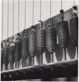
Befestigung und Spannen der Drähte durch rostfreie Stahl-Détail des ressorts en acier inoxydable
