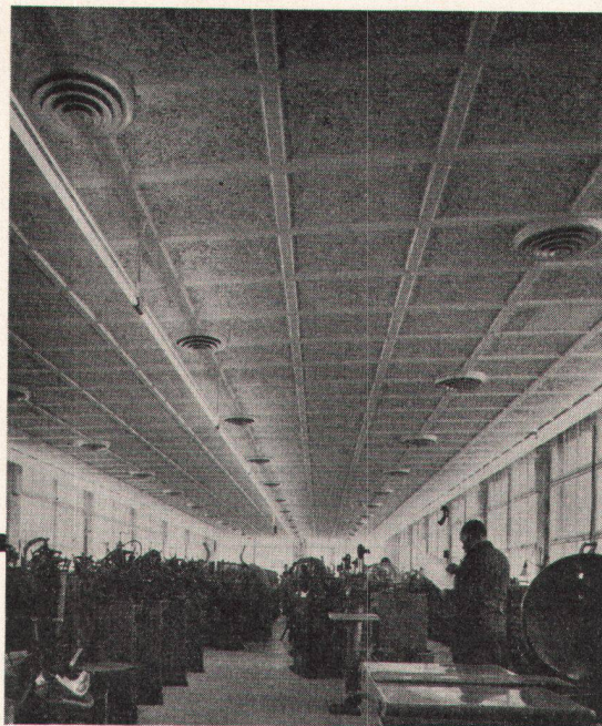
Klimaanlage „System Häusler“ in Uhrenfabrik
