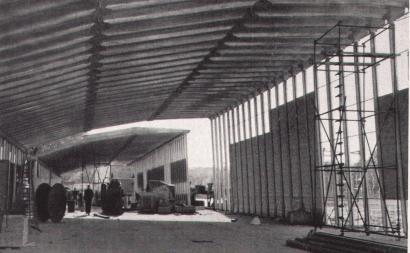
Detail der Dachkonstruktion; Träger aus gefaltetem Aluminium-
