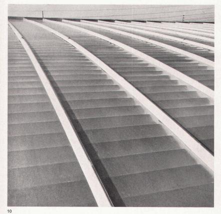
10 Struktur eines Aluminiumdaches aus Standardelementen Toiture composée d'éléments en aluminium
