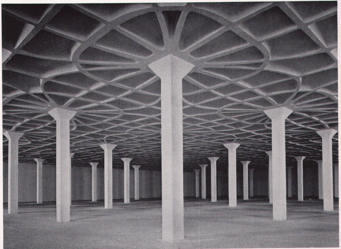
Raum mit Pilzsäulen und Rippendecke Intérieur. Construction en champignon avec nervures Interior. Mushroom construction with rib slab
