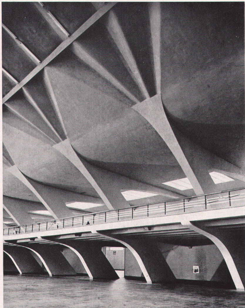
1 Ausstellungshalle in Turin. Ingenieur und Architekt: Pier Luigi Nervi, Rom. Stützpfiler und seitliche Galerie Bâtiment d'exposition à Turin, détail. Pier Luigi Nervi, ingénieur Exhibition building in Turin, Italy, detail. Pier Luigi Nervi, engineer Photo: Vasari, Rom
