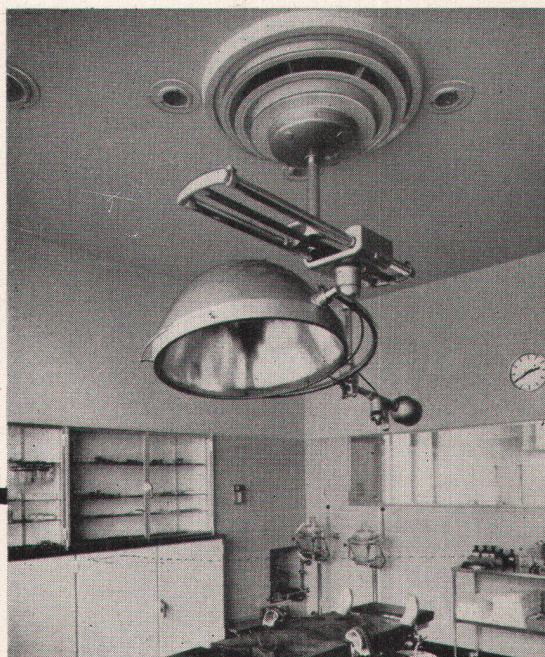
Klimaanlage «System Häusler» in Operationssaal eines Spitals
