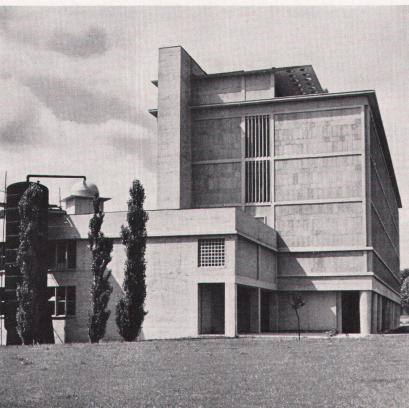
Les éléments de remplissage des façades, allèges, appuis, claustras ont été exécutés en usine, à Orléans, et ont été posés dans les feuillures réservées dans les poteaux au moment du coulage. Les appuis, en particulier, ont été exécutés en béton avec surface de porphyre vert. Le couronnement du 4º étage est constitué par des voûtes en berceau, en voile mince de béton armé. Les terrasses sont exécutées avec étanchéité d'asphalte et préservées par des dalles de béton de gravillon armées et lavées.
