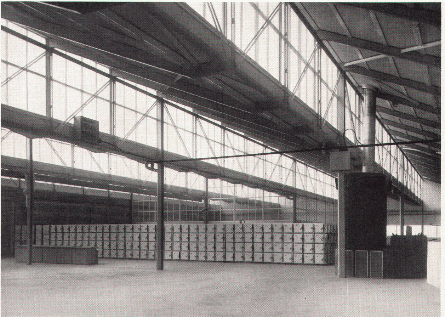
10 Fabrikationshalle mit Sheds in Stahlkonstruktion Intérieur de l'usine Interior of the factory
