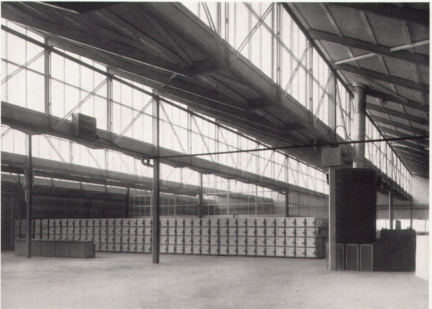
10 Fabrikationshalle mit Sheds in Stahlkonstruktion Intérieur de l'usine Interior of the factory
