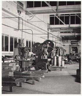
Arbeitsplätze. Leitungen für Strom, Druckluft usw. offen verlegt, daher jederzeit zugänglich und veränderlich Détail de l'intérieur. Les conduites d'électricité, d'air comprimé, etc. sont facilement accessibles, permettant ainsi des changements ultérieurs
